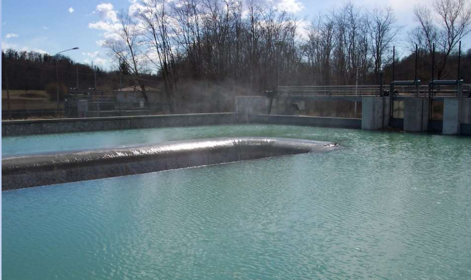
CANALE SCOLMATORE CORNO- TAGLIAMENTO
